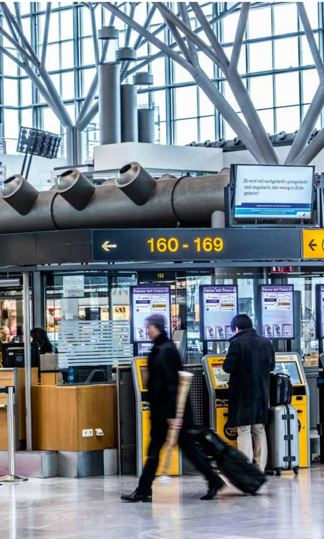
*Drei Düsen für die frische Luft: Direkt über den Check-in-Schaltern strömt sie ins Terminal. Die großen Türme unter der Decke saugen Verbrauchtes wieder ab.*
