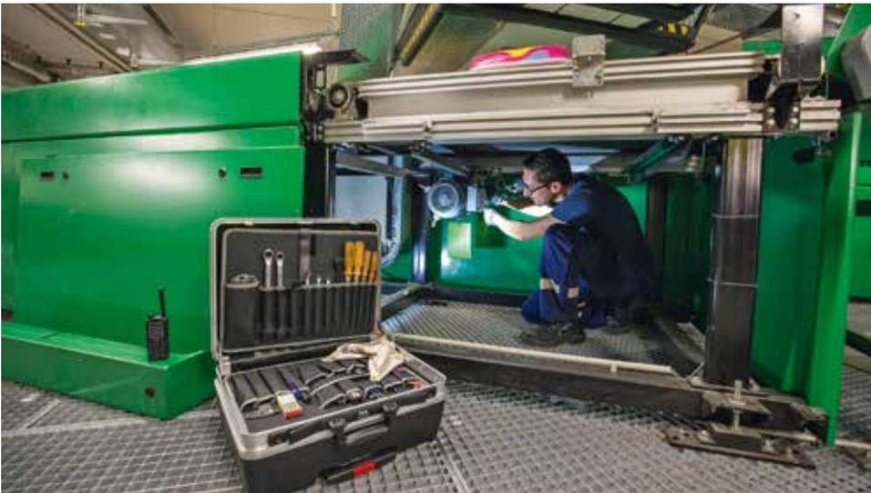
*Carsten Kleine muss gelenkig sein, wenn er unter dem Förderband im Gepäckverteiler arbeitet. Denn nur so bekommt der Mechaniker den Antrieb wieder flott.*
