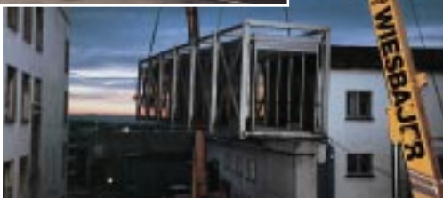
... und mit einem speziellen Kran durch die Lüfte bewegt
