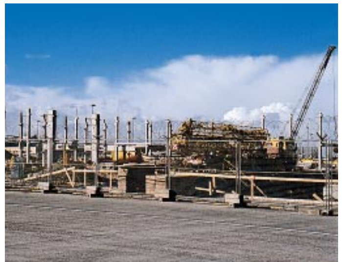
Im März begann der Stahlbau am DaimlerChrysler-Hangar
