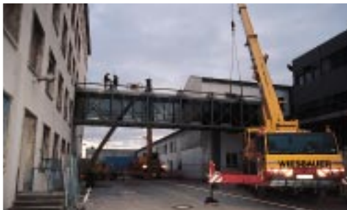
Vorsichtig wird die Brücke losgemacht ...
