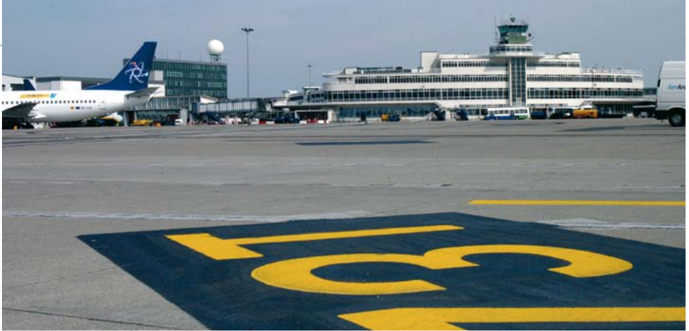
Das 1941 eröffnete und mit mehreren Architekturpreisen prämierte Terminal ist der Brücke eines Luxusliners nachempfunden.
