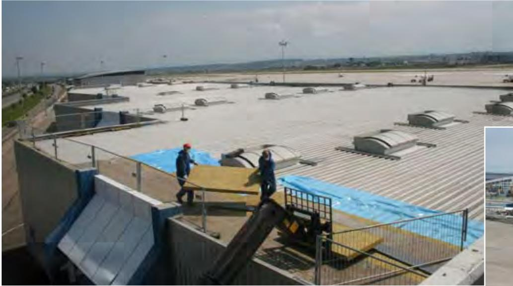
*Bevor die großen Bagger rollten, trugen die Bauarbeiter erst mal die Wärmedämmung des Daches ab. An die Stelle der alten BVD-Halle kommt das neue Kerosinlager.*
