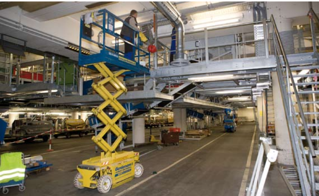
Der Einbau der neuen Gepäckförderanlage findet hinter den Kulissen statt – ebenso wie das Röntgen der Koffer.
