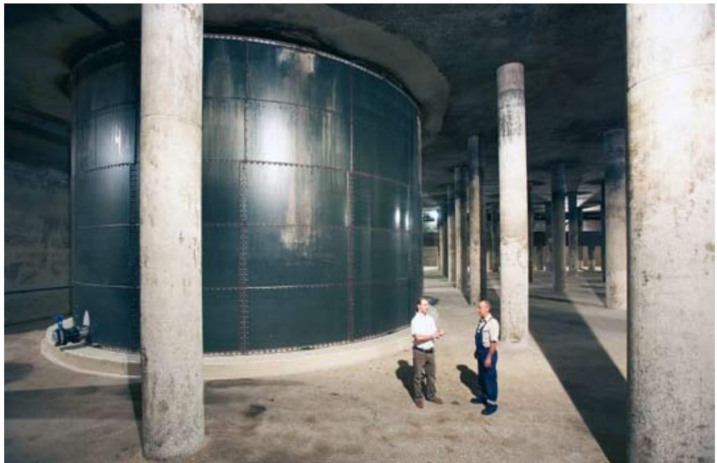
Abwasser vom Winterdienst oder von der Flugzeugenteisung wird erst einmal gesammelt. Insgesamt 104.000 Kubikmeter fassen die Speicherbecken.
