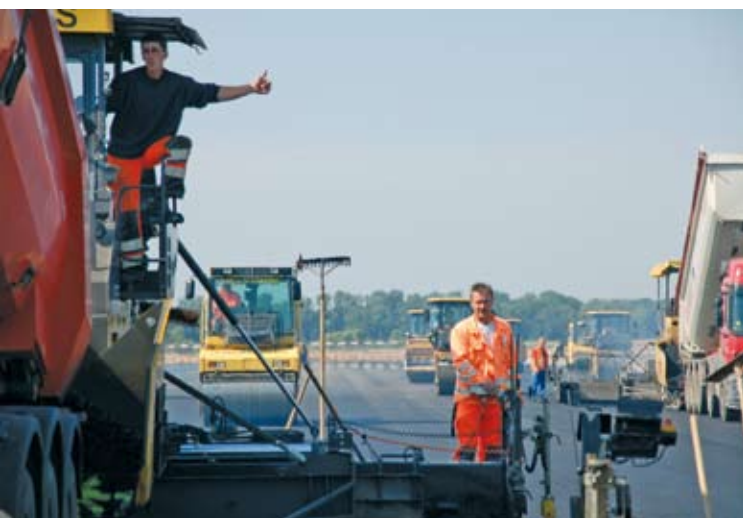
Rund ein Jahr baggerten und bauten die Handwerker und installierten dabei nicht nur die Befeuerung, sondern verbreiterten auch die Piste.
