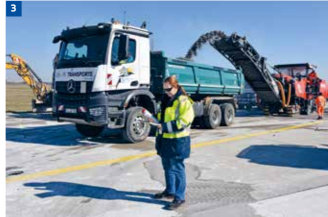
↑ Claudia Bier ist Tiefbauchefin am Airport. Sie hatte die siebzig Lkw und Großgeräte, die am STR gleichzeitig unterwegs waren, im Blick.
