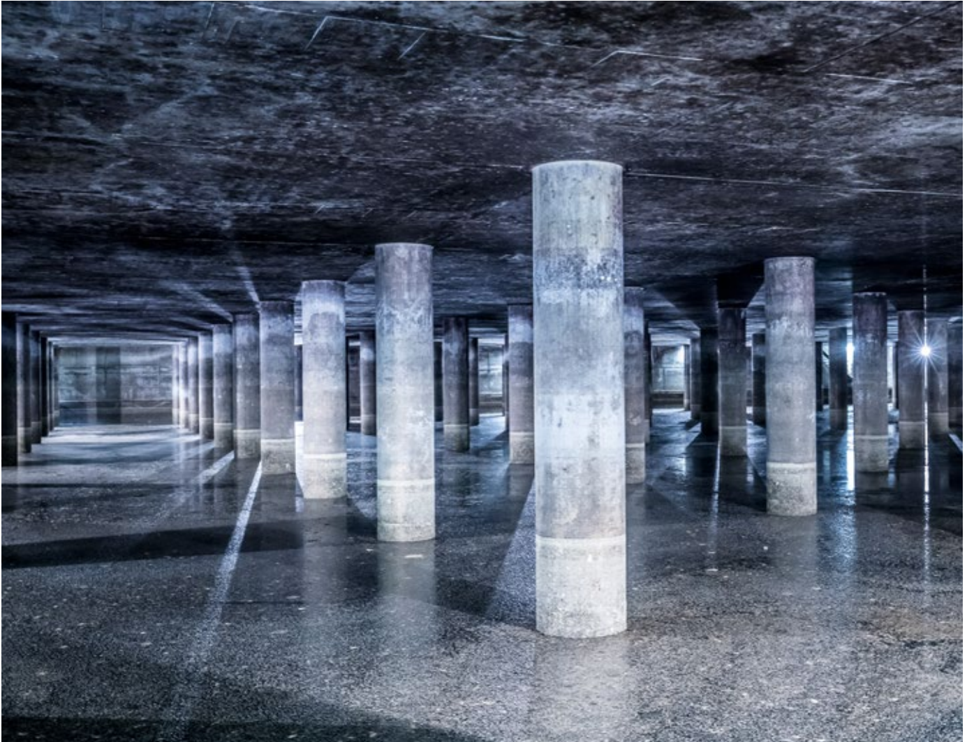
Rund 700.000 m 3 Regen und Schnee sind 2017 innerhalb des Flughafenzauns gefallen. Damit selbst bei starkem Niederschlag kein Hochwasser in der Umgebung verursacht wird, fängt der Flughafen dieses Oberflächenwasser zuerst in großen unterirdischen Speicherbecken auf. Erst danach wird es kontrolliert in umliegende Bäche und Seen geleitet.
