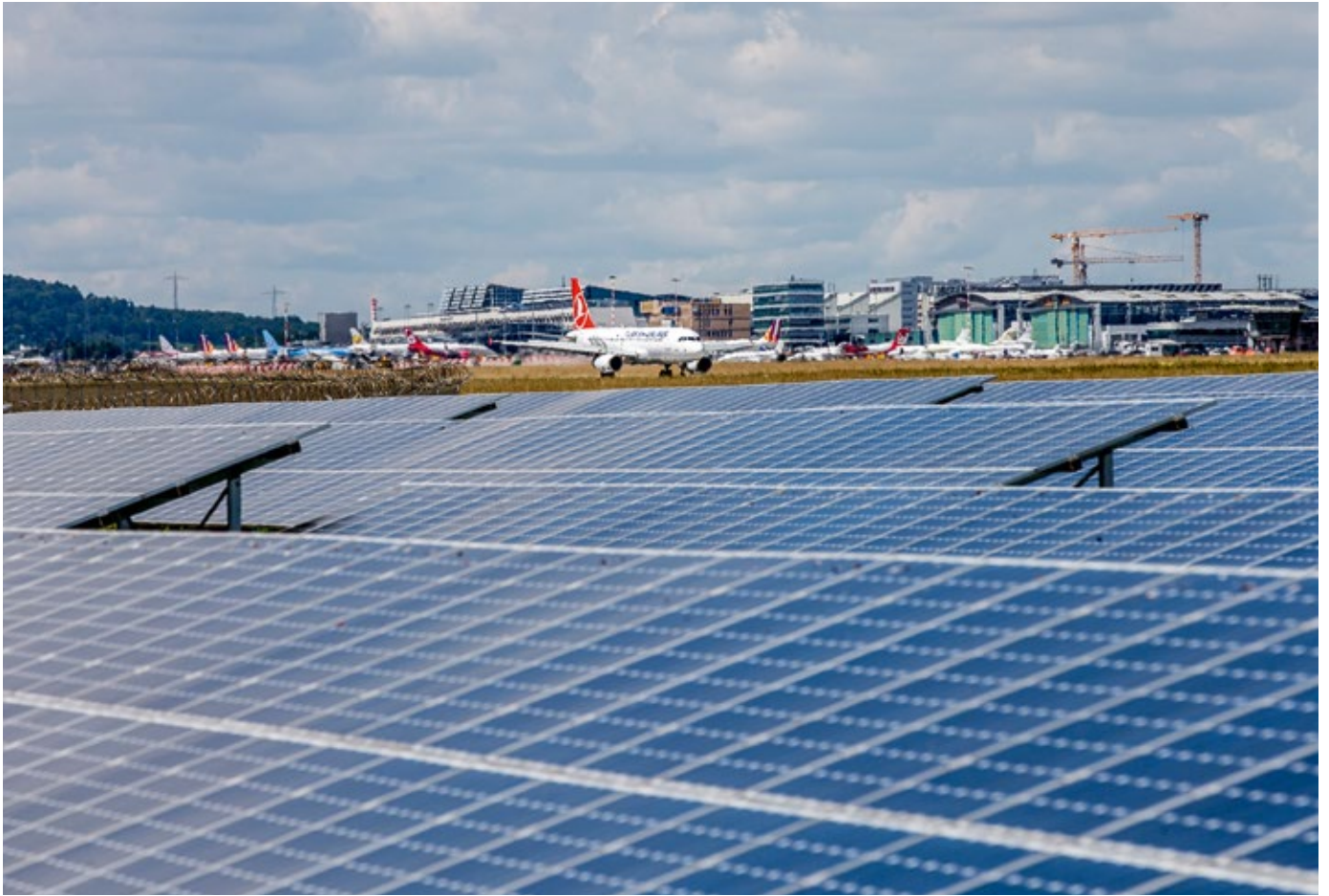
Etwa zwei Fußballfelder würden alle fünf Solaranlagen am Airport derzeit zusammen bedecken. Damit wir unsere Klimaziele erreichen, werden wir auch in Zukunft weiter auf selbst produzierten Grünstrom setzen.
