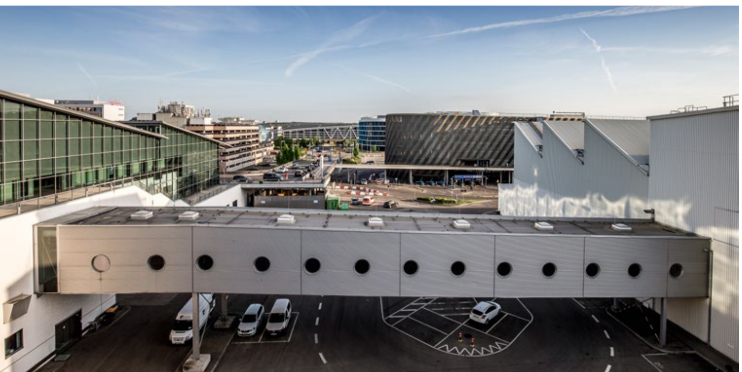
Noch verbindet dieser Übergang die Terminals 3 und 4. Diese Baulücke soll geschlossen und das T4 erneuert werden. Das Projekt startet mit einem Architektenwettbewerb.
