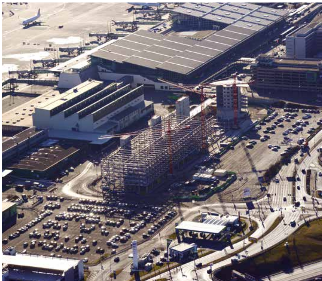
Vom Parkhaus P 14 können Passagiere und Besucher zukünftig über einen Steg direkt in das Terminal 3 auf die Abflugebene wechseln.
