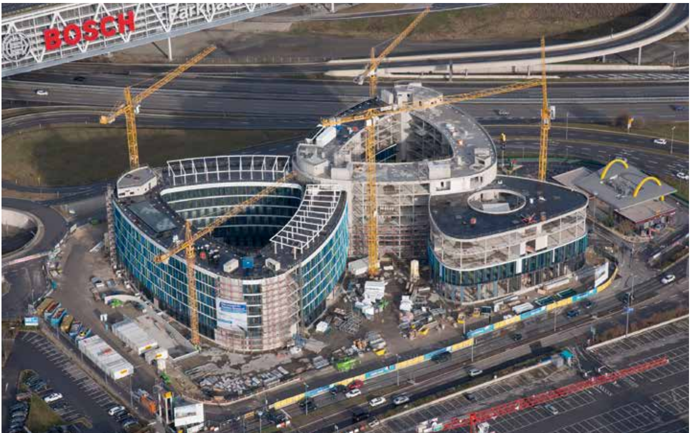
Das New Office Airport Stuttgart (NOAS) konnte im November 2014 Richtfest feiern. Als Hauptmieter wird ab Anfang 2016 die Unternehmensberatung Ernst & Young mit über 1.500 Mitarbeitern ihrer Deutschlandzentrale dort einziehen.
