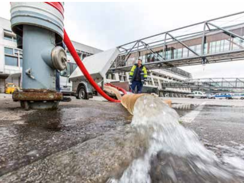
Da kommt ordentlich etwas heraus: Die rund neunzig Hydranten auf dem Airport-Gelände werden regelmäßig durchgespült.
